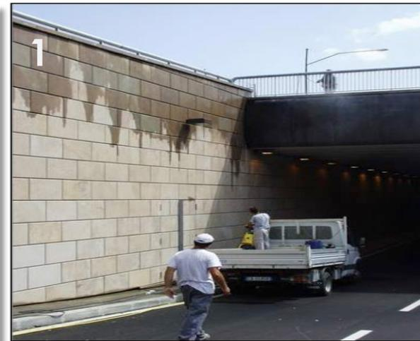
**1.** Pulizia con SERVICE ACIDO per eliminare tracce di posa e di pulviscolo atmosferico
